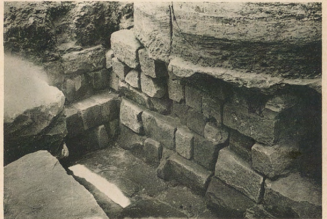
2. — Fondations de la colonne 24, angle N.-O. de la Salle Hypostyle.
